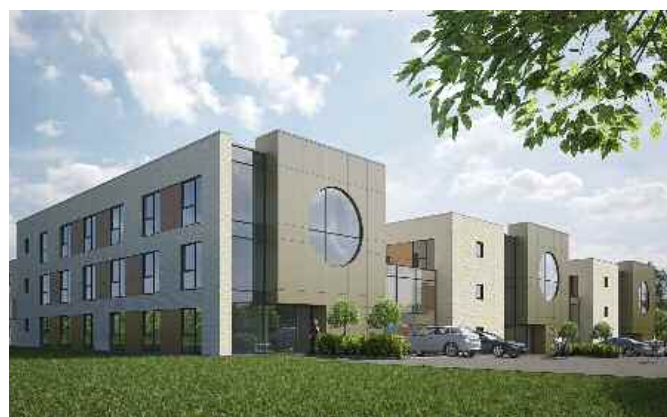
Bis zum Frühjahr 2015 entstehen campusnah 239 Wohnplätze.
